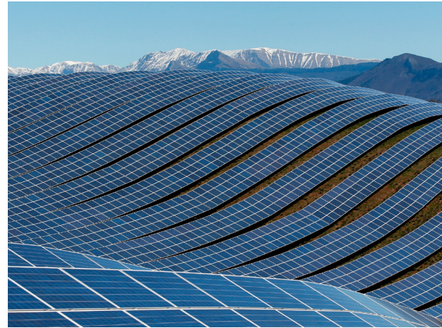
Les Mées solar farm (Alpes-de-Haute-Provence, France).
